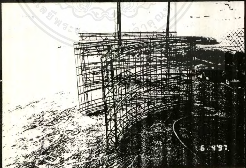
ลักษณะของโครงเหล็กเสริม Type B
