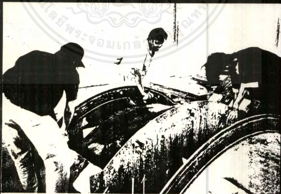
ทาน้ำมันลงบนแบบหล่อ
