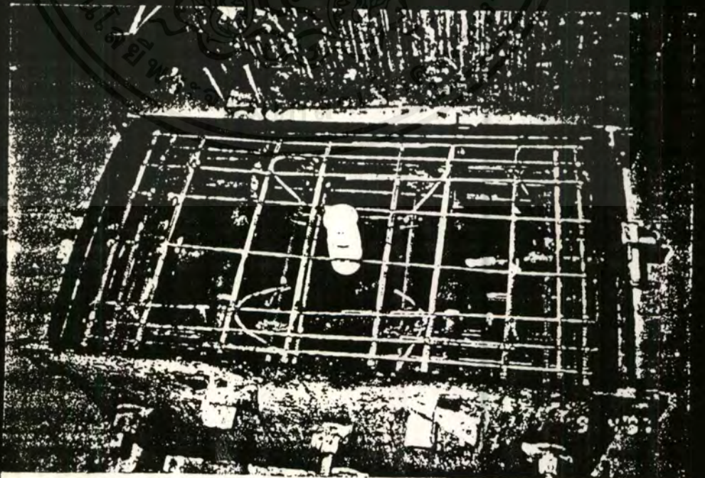
แสดงแบบหล่อที่พร้อมจะเทของ Type K
