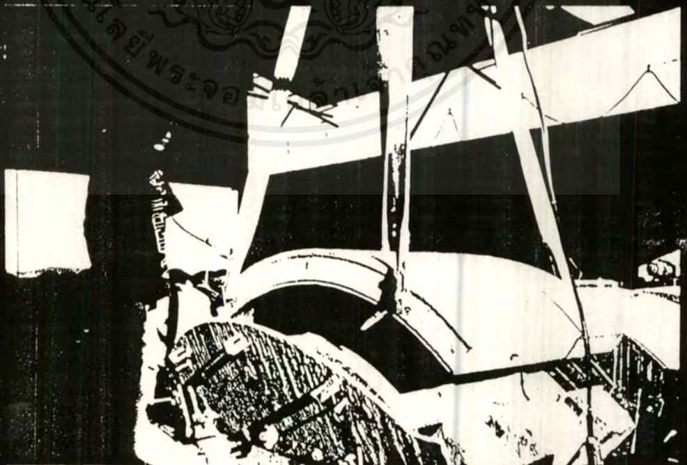
ขมดยก Segment ออกจากแบบหล่อ
