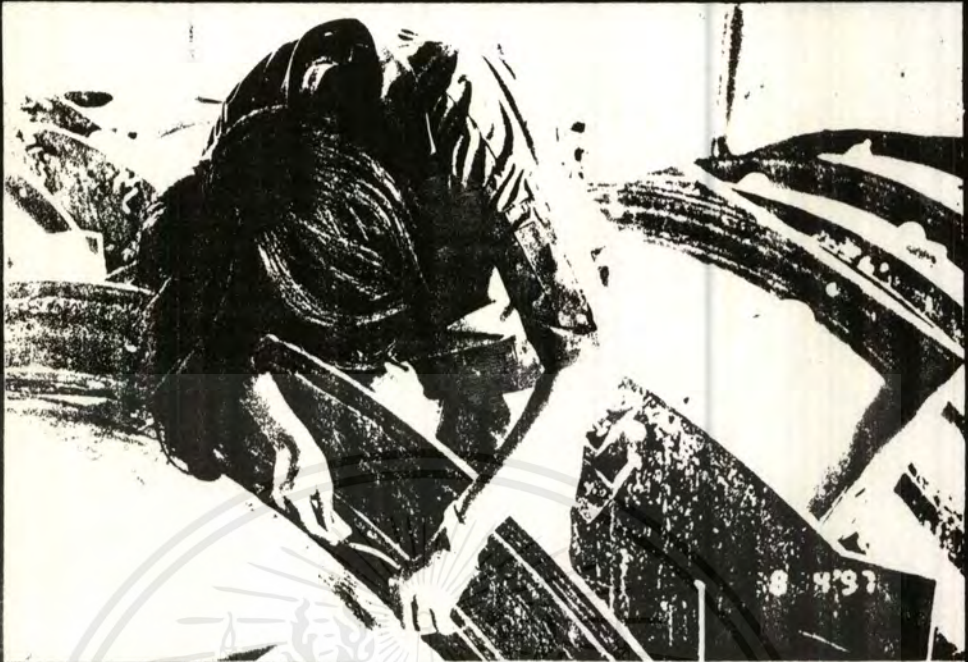
ติดเทปป้องกันน้ำคอนกรีตไหลออก
