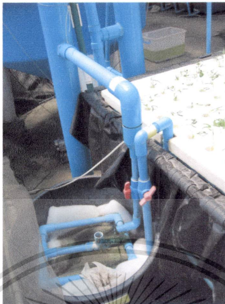
ภาพที่ 3.17 ระบบกรองของระบบ DRFT-Fish
