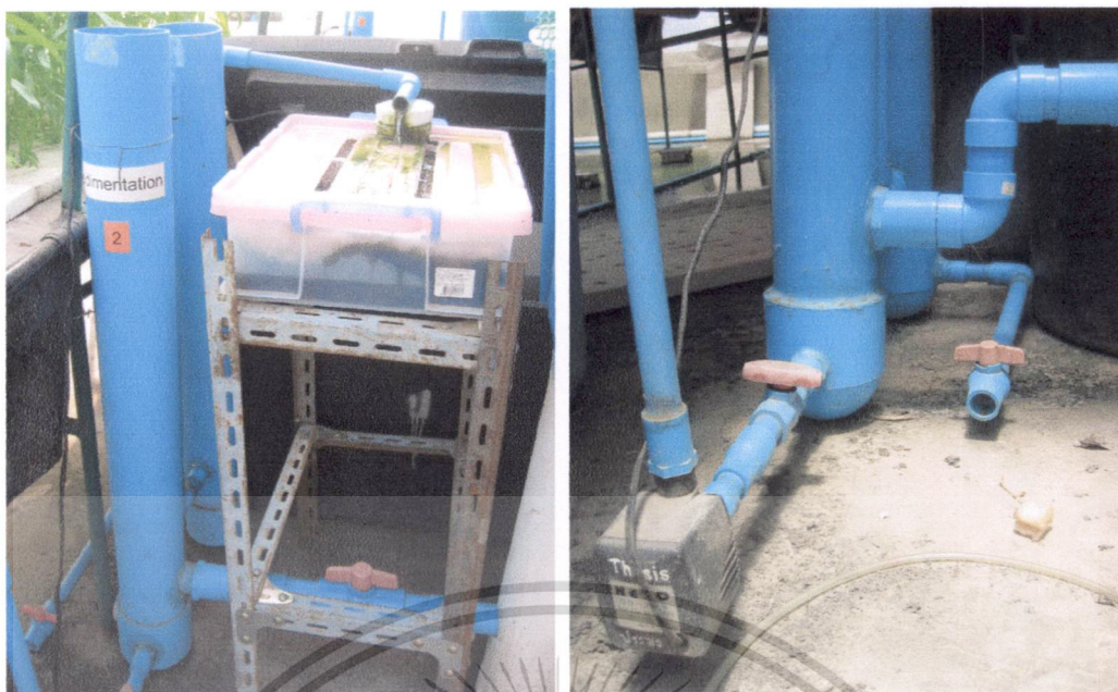
ภาพที่ 3.3 ถังกรองชีวภาพและถังตกตะกอน (ก) ลักษณะของปั๊มดูดตะกอนที่เชื่อมต่อกับถังตกตะกอนและวาล์วเปิด-ปิด (ข)
