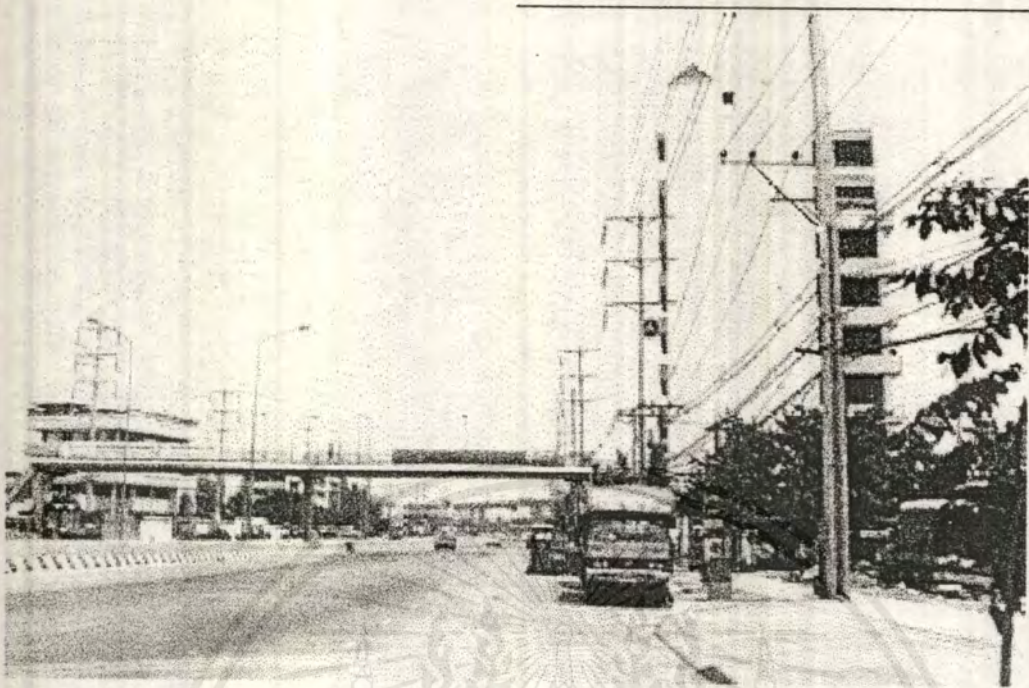
รูป 6.25 บริเวณสถานีโรงแรมมณเฑียร
