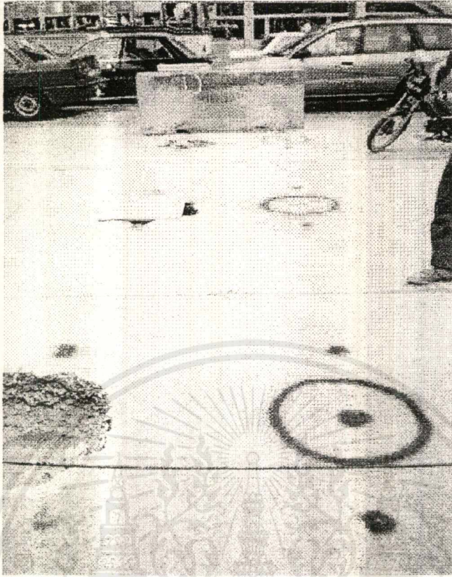
รูปที่ 4.9 กำหนดตำแหน่งที่จะทำการเจาะให้แน่นก่อนการทำงาน
