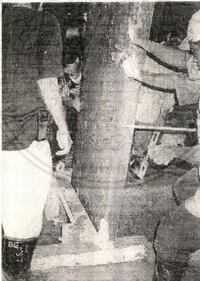
รูปที่ 4.40 การติดตั้งและการยึด Stop End ไว้
