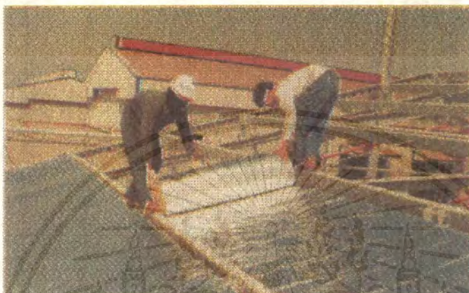
รูปที่ 4.42 การติดตั้งฉนวนใยแก้วบนโครงหลังคา
