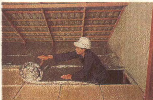
รูปที่ 4.41 การติดตั้งฉนวนใยแก้วบนฝ้าเพดาน
