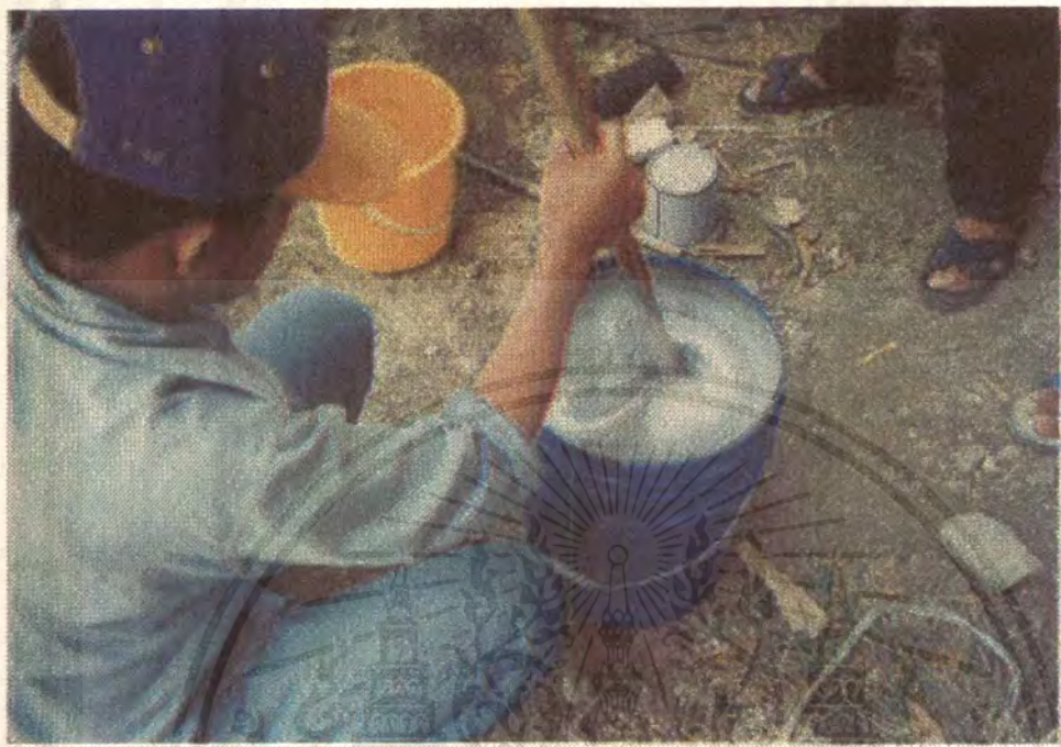
รูปที่ 4.39 การผสมเซรามิกก่อนทำการติดตั้ง
