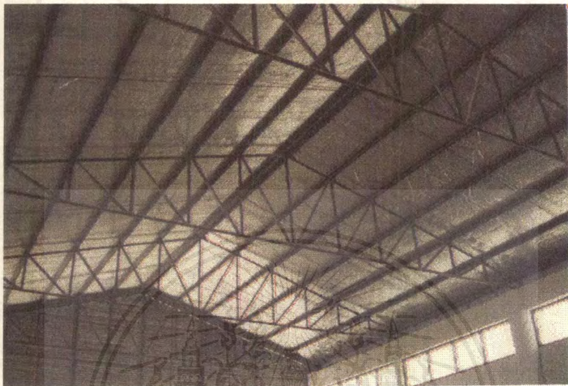
รูปที่ 4ข แสดงการนำฉนวนใยแก้วหุ้มแผ่นอะลูมิเนียมติดตั้งได้หลังคา
