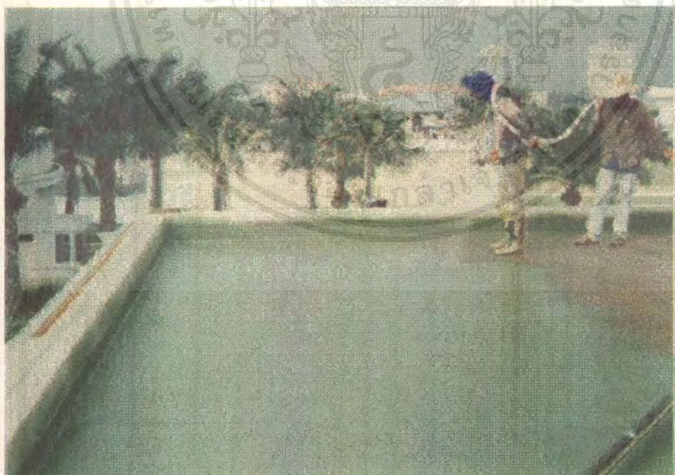
รูปที่ 4.40 การพ่นเซรามิกบนคอร์ตฟุตบอลลูก
