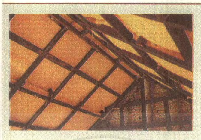
รูปที่ 6๗ การนำแผ่นใยแก้วมาเหนือโครงหลังคาไม้
