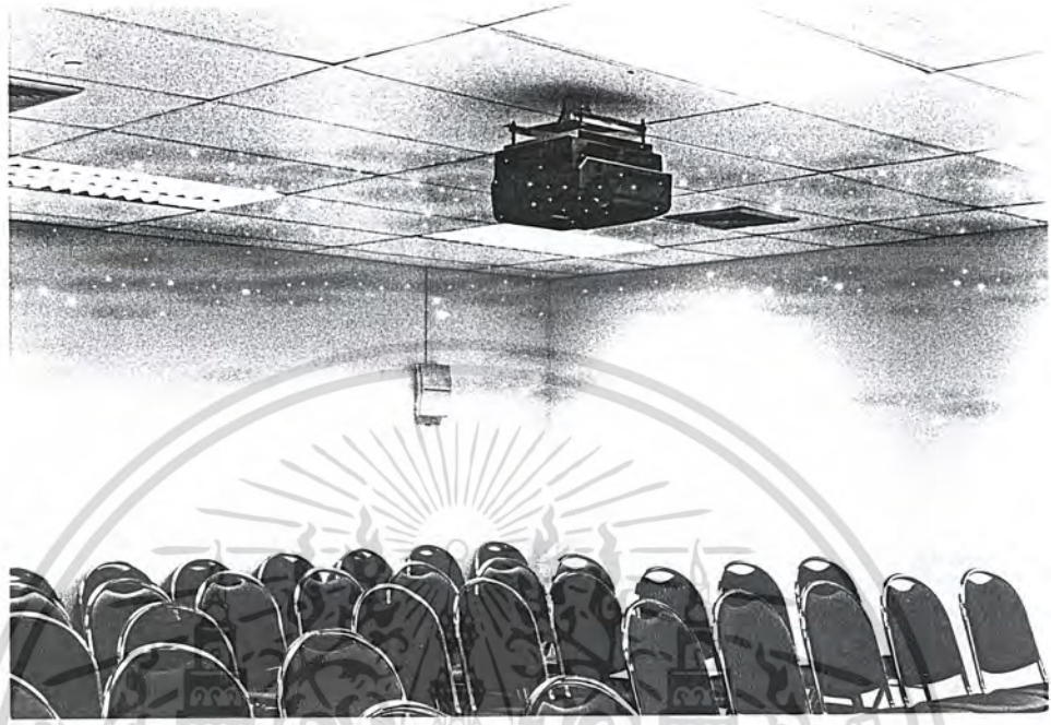
รูปที่ 2.153 แสดงลักษณะการแขวนเครื่องฉายซึ่งใช้แบบเลนส์เดี่ยว และที่นั่งชมภาพยนตร์
