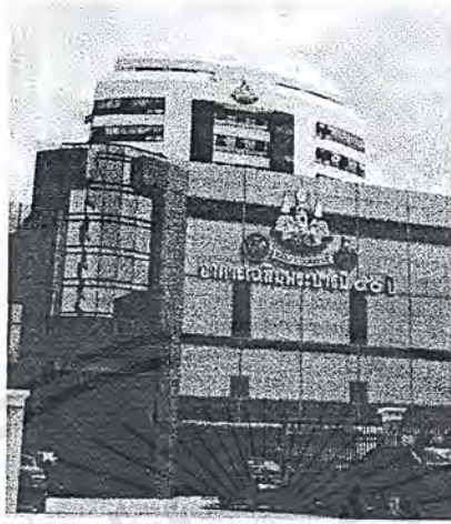
รูปแสดงพื้นที่ด้านหน้าอาคาร
