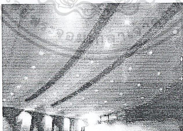
ภาพที่ 3.12 แสดงการออกแบบเพดานโค้งเป็นลอนเพื่อผลในการกระจายของเสียง ง่ายในการจัดระบบแสงสว่างและระบบปรับอากาศภายใน
