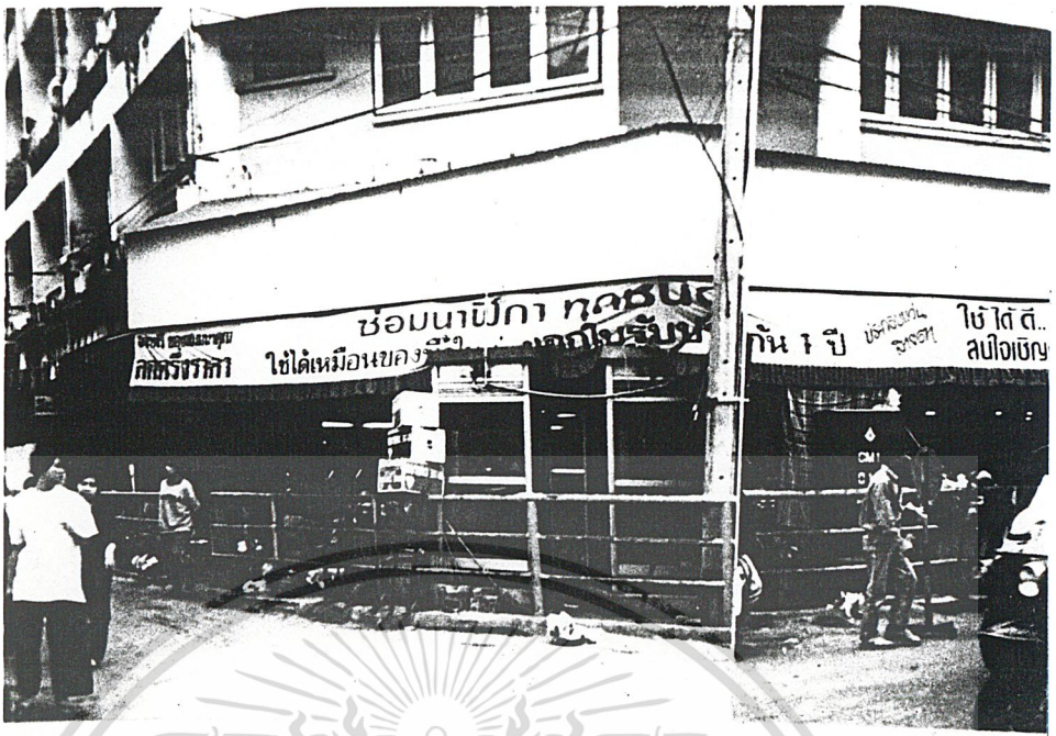
ภาพที่ 18 แสดงอาคารพาณิชย์บริเวณถนนอุดมผล
