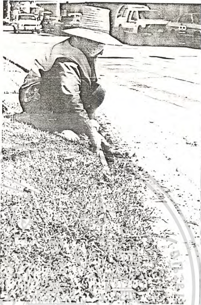
ภาพที่ 4.5 แสดงการใช้เลียมตัดแต่งความลึกของร่อง
