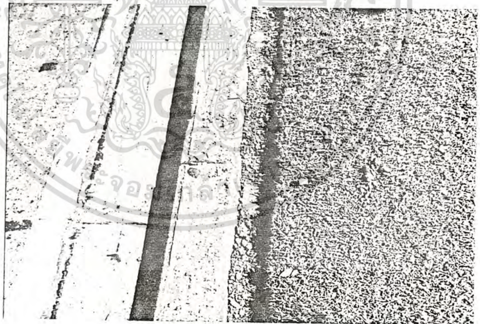
ภาพที่ 4.8 แสดงลักษณะเกาะกลางถนนที่ถูกเซาะร่องแล้ว
