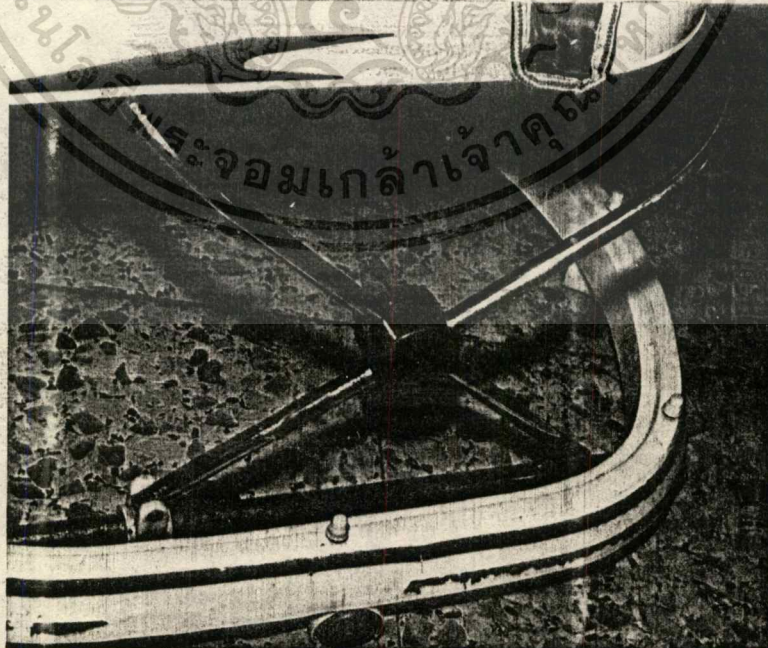
ภาพที่ 4.59 แสดงโครงขาเหล็กที่กลมเส้นผ่าศูนย์กลาง 6 นิ้ว ชูโครเมียม มีจุดหมันทัวซาเป็นพลาสติก
