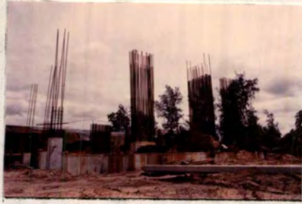
ภาพที่ 32 แสดงสถานที่ก่อสร้างโครงการ
