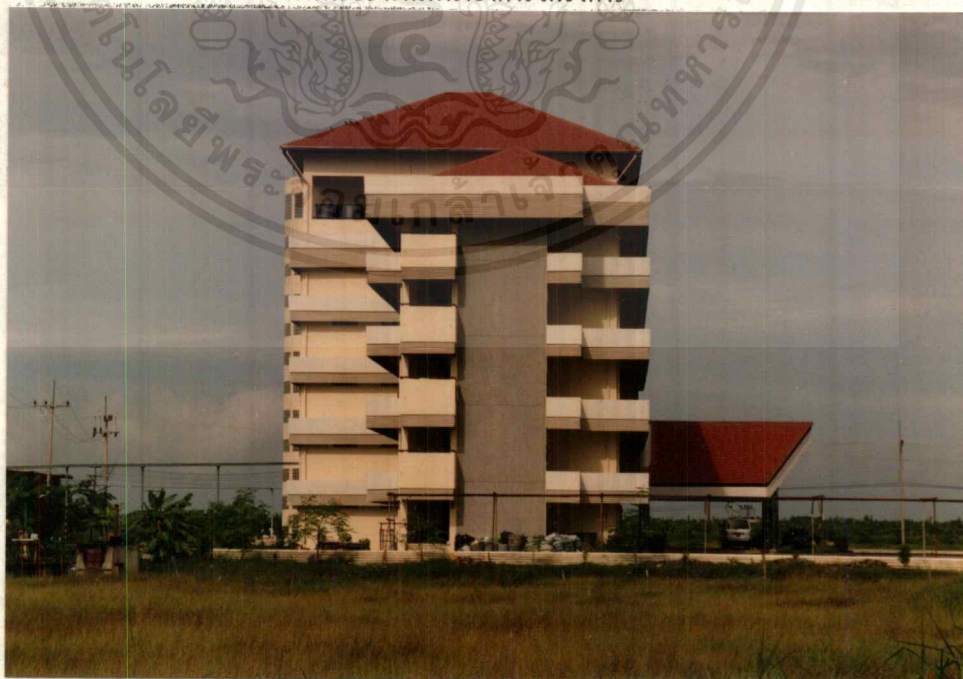
ภาพที่ 67 ด้านขวาอาคาร โครงการ
