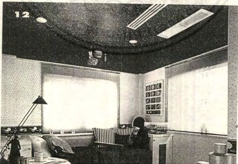
ภาพที่ 2.11 แสดงการติดตั้งหน้ากากหัวจ่ายและกลบลม
