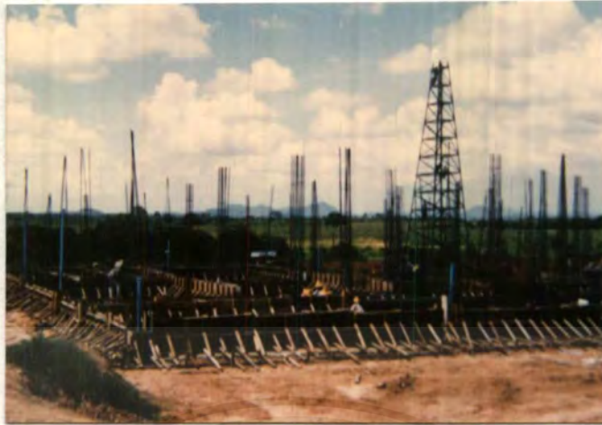
ภาพที่ 41 แสดงการดำเนินการก่อสร้างตัวอาคารซึ่งปัจจุบันกำลังดำเนินการก่อสร้างอยู่
