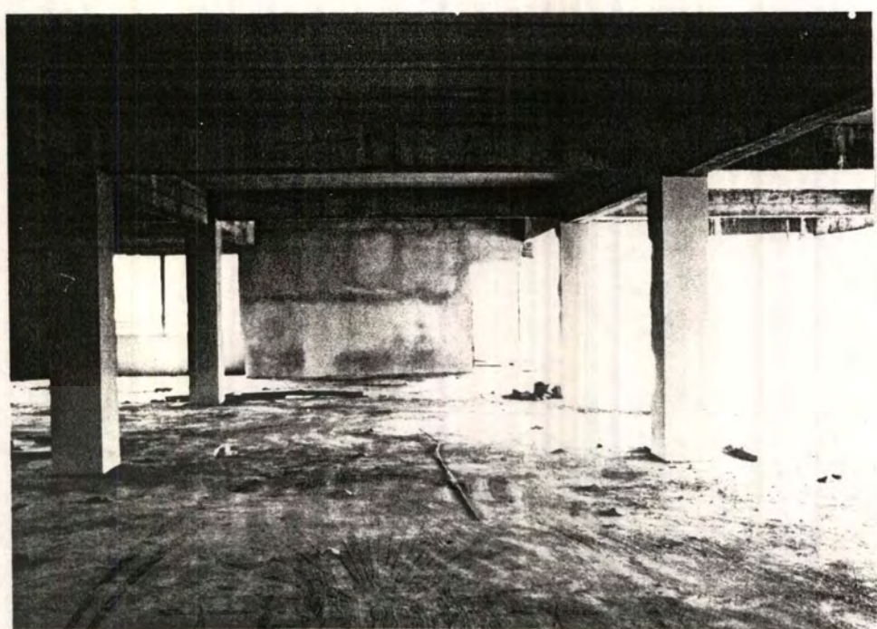
ภาพที่ 3.8 แสดงลักษณะ โครงสร้างภายในอาคาร
