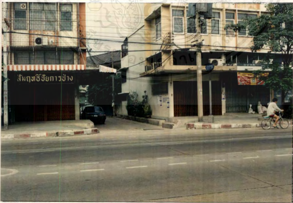
ภาพที่ 34 แสดงภาพทัศนียภาพติดกับอาคารพาณิชย์ขนาด 4 ชั้น
