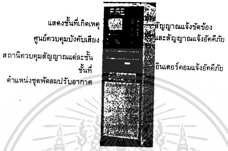
ภาพที่ 2.14 แผงควบคุมอักคิภัยสำหรับสำนักงานอาคารสูง
