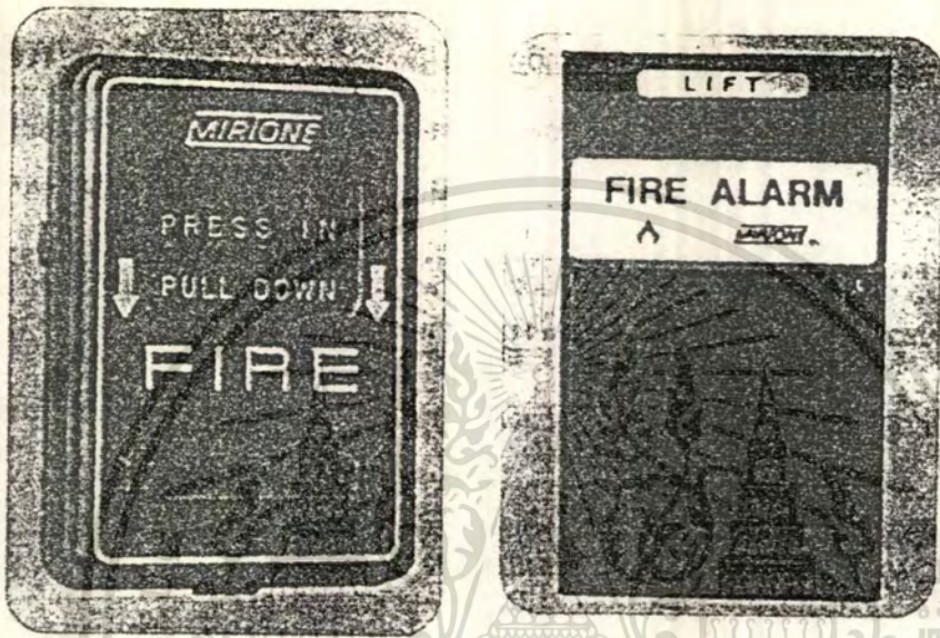
ภาพที่ 2.11 แสดงสถานีแจ้งสัญญาณเตือนภัยแบบมือดึงหรือกด
