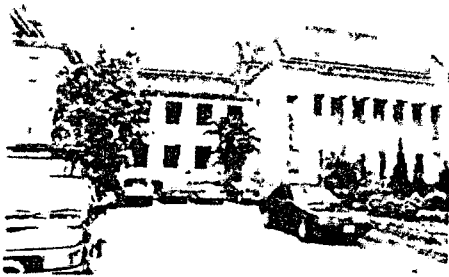
< แสดงส่วนทางสถาปัตยกรรมช่องแสง ทางสัญจรหลักภายในอาคารอำนวยการ (ทางด้านซ้ายทางทิศใต้)
