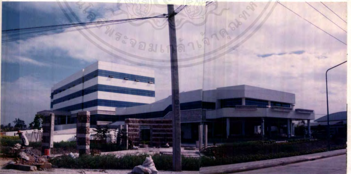
ภาพที่ 37 สภาพโดยทั่วไปของตัวอาคารด้านทิศตะวันตก
