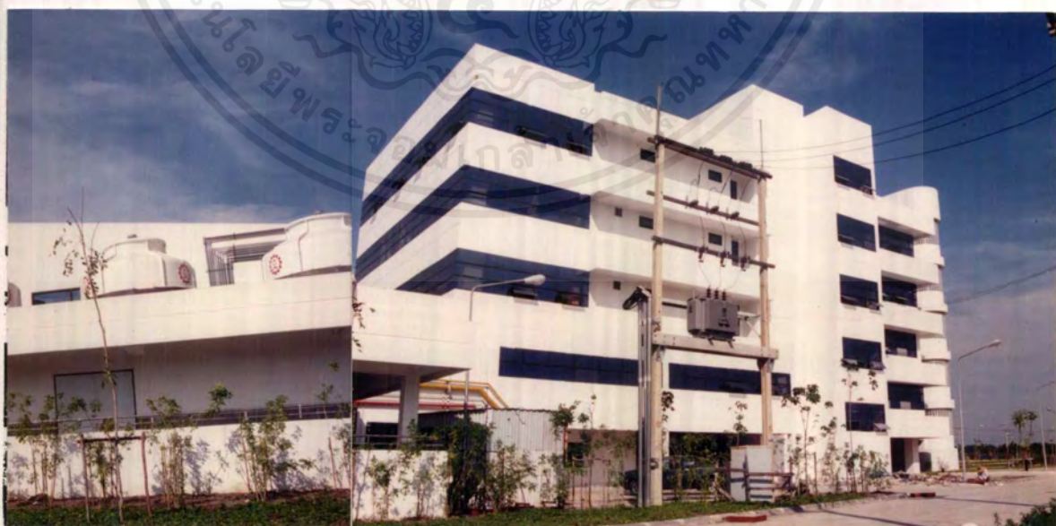
ภาพที่ 35 สภาพโดยทั่วไปของตัวอาคารด้านทิศใต้
