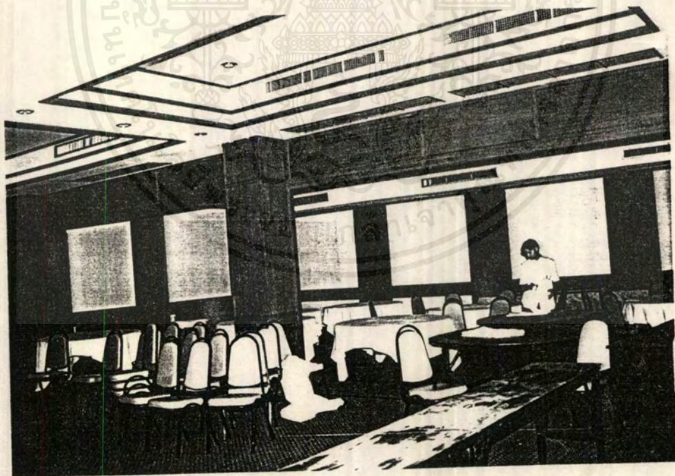
ภาพที่ 71 แสดงการตกแต่งภายใน พื้นปูพรมผนังกรุวอลเปเปอร์ทำกรอบไม้อัดสัก เพดานยิมซั่มบอร์ด ติดคิ้วไม้ขนาด 5 ซม. ชุดเก้าอี้ใช้แบบสำเร็จรูป
