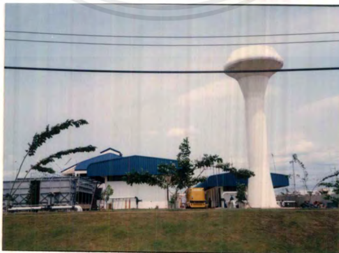
ภาพที่ 3.3 แสดงสถานีบำบัดน้ำเสียภายในนิคมอุตสาหกรรมระยอง เอกสารนี้เป็นเอกสารสงวนลิขสิทธิ์สำหรับใช้ภายในองค์กรเท่านั้น ไม่ว่ากรณีใดๆ ทั้งสิ้น อีกทั้งห้ามมิให้ตัดแปลงเนื้อหาและต้องอ้างอิงถึงเจ้าของเอกสารทุกครั้งที่มีการนำไปใช้
