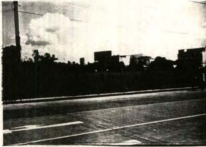
รูปที่ 58 ถนนด้านข้างโครงการ
