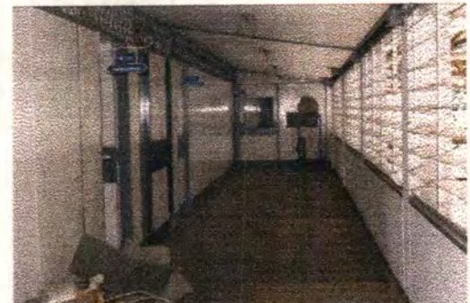
รูปที่ 3.7 ทางเดินหน้าห้องเรียนคณะวิชาไฟฟ้า
