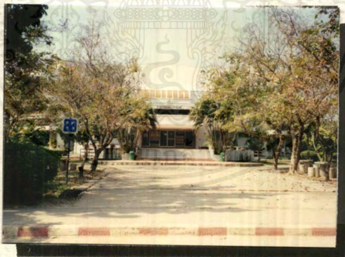
ภาพที่ 19 อาคารอเนกประสงค์ (โรงยิม)
