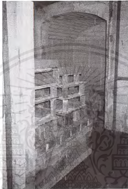
รูปที่ 3.9 การจัดก่อนวัสดุเข้าเตาเผา
