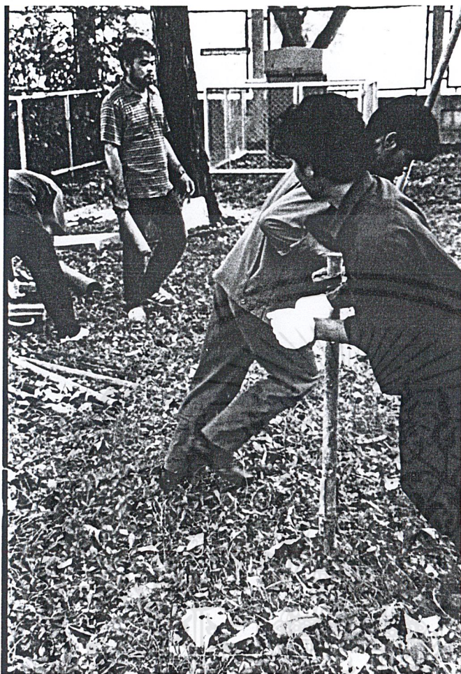
รูปที่ ข1 และ ข2 แสดงการติดตั้งเสาเค้าน
