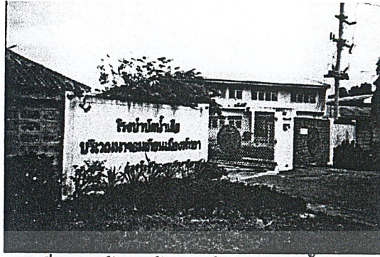
รูปที่ 4-43 ด้านหน้าทางเข้าโรงบำบัดน้ำเสีย
