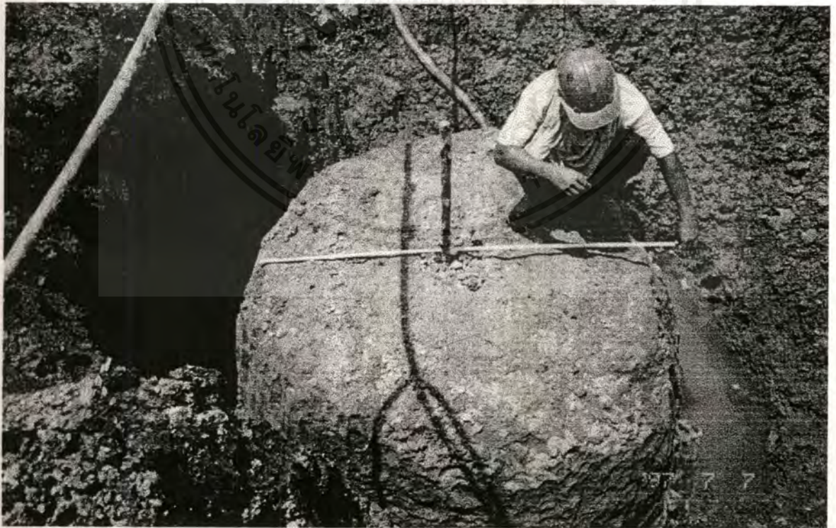
รูปที่ 6.11 แสดงการวัดขนาดของ Jet Grouting Pile (โครงการปากพ่อง)
