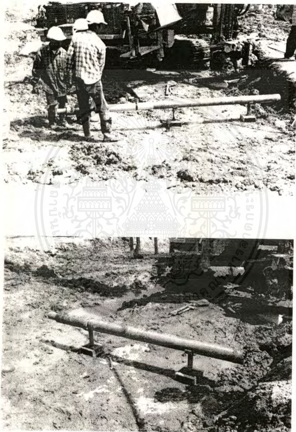
รูปที่ 6.3 การประกอบระบบอกเก็บตัวอย่าง (โครงการ MRTA)
