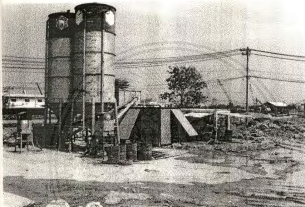
รูปที่ 5.2 ซิโลเก็บซีเมนต์และน้ำ (โครงการ MRTA)
