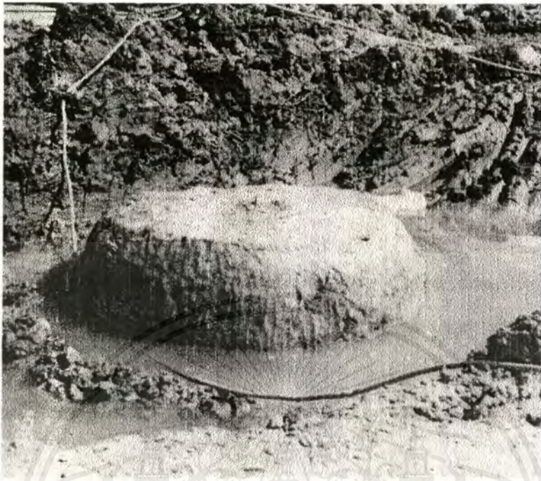
รูปที่ 6.10 แสดงการขุดเพื่อตรวจสอบขนาดของ Jet Grouting Pile (โครงการปากพ่อง)
