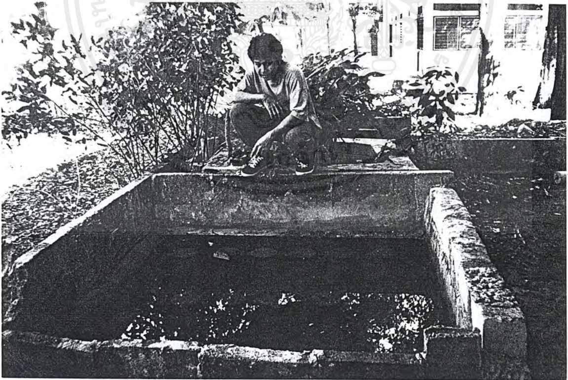
รูปที่ 4.11 แสดงแบบหล่อที่เทคอนกรีตเสร็จแล้ว
