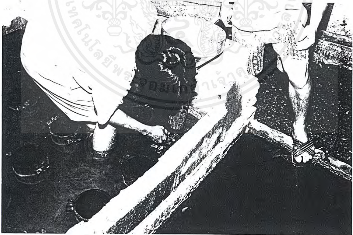
รูปที่ 4.7 แสดงการปล่อยปลายท่อทริมมีลงสู่กันแบบหล่อ
