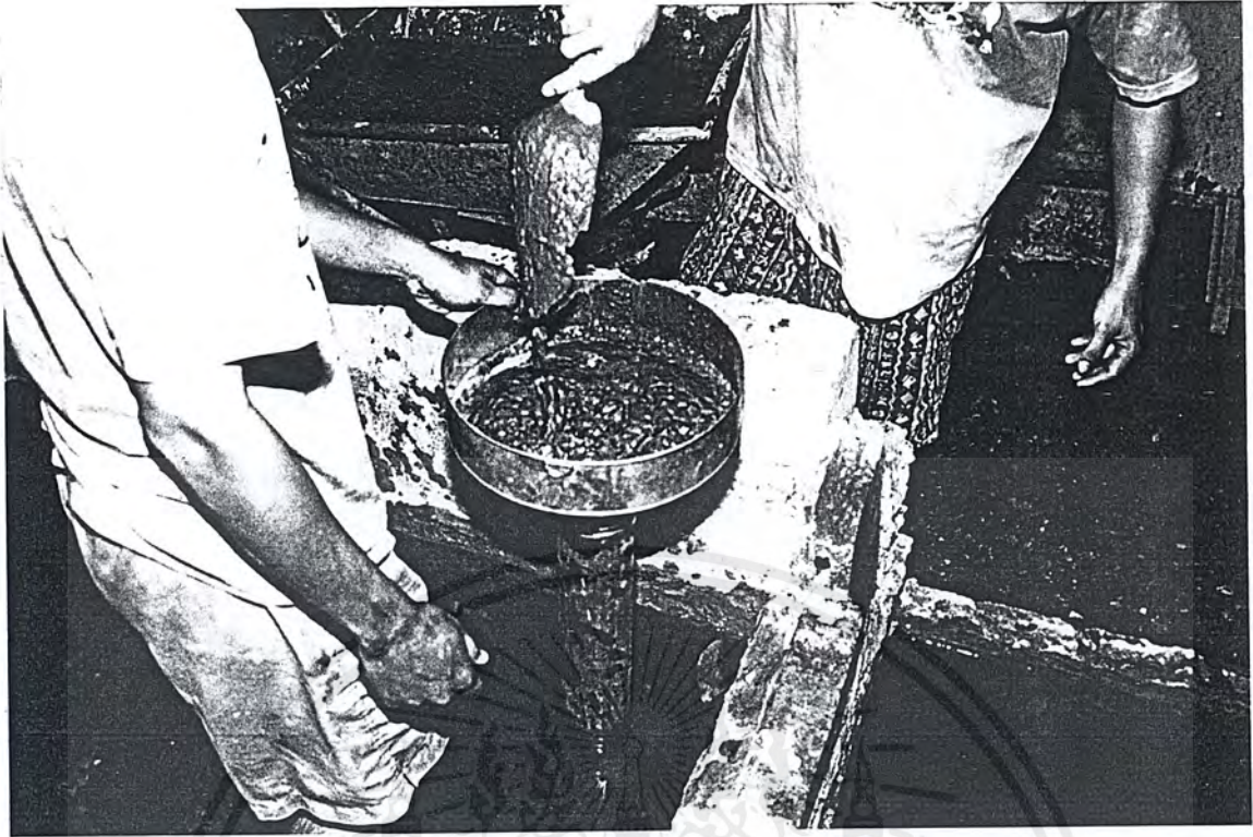
รูปที่ 4.8 แสดงการเติมคอนกรีตลงในท่อทริมมี
