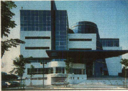
ลักษณะอาคารภายนอก
