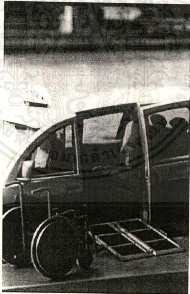
ภาพประกอบ 4.2.23 แสดงการใช้พื้นเฉียงสำหรับ WHEELCHAIR
