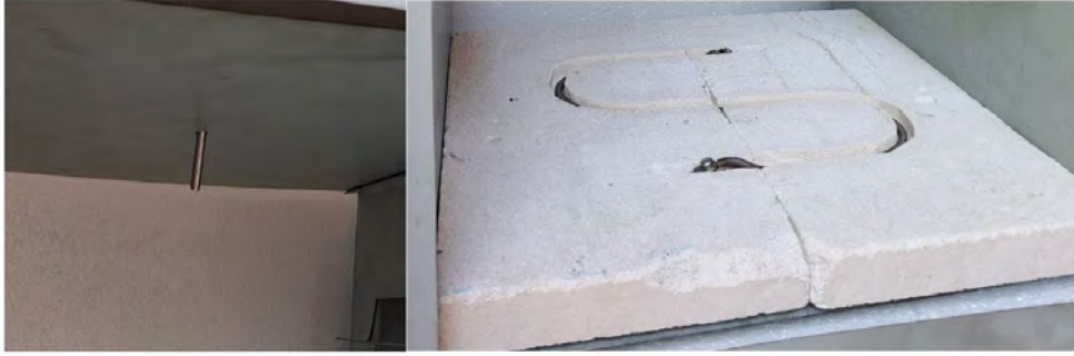
รูปที่ 3.12 แสดงโพรบวัดอุณหภูมิเบอร์ DS18B20 และขดลวดความร้อนติดตั้งในร่องอิฐมวลเบา
