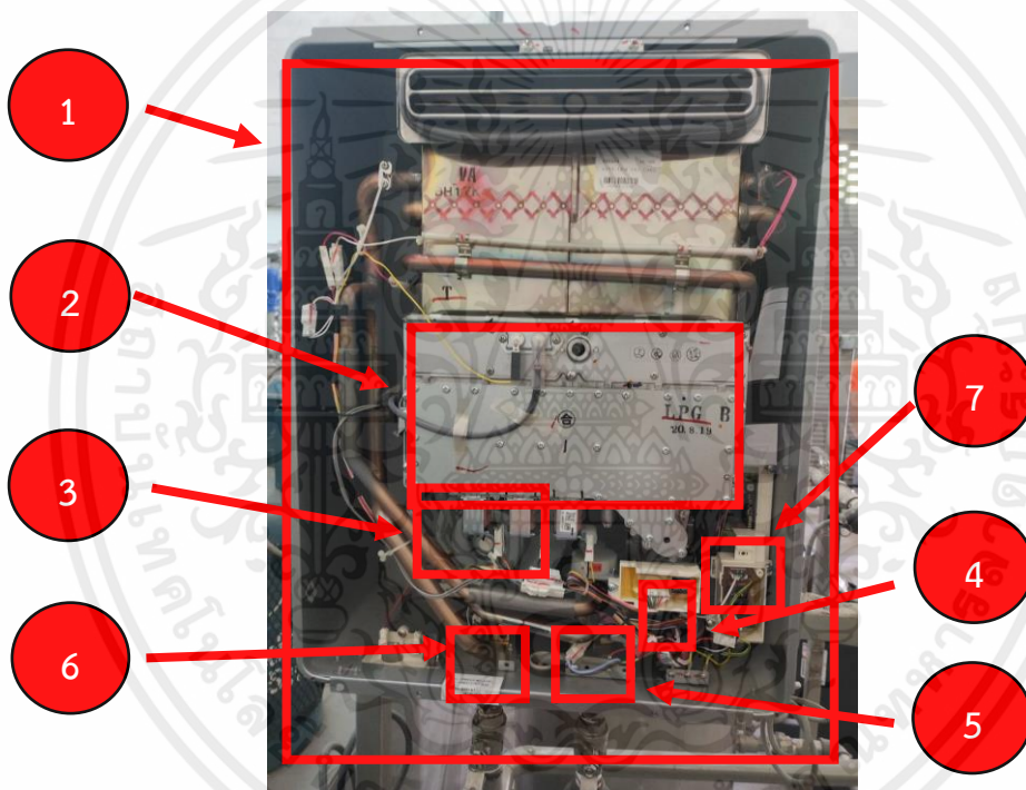
รูปที่ 3.1 องค์ประกอบเครื่องทำน้ำร้อนแก๊ส
