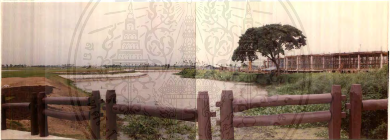
รูปที่ 197 บ่อน้ำด้านหลังอาคารสโมสร
