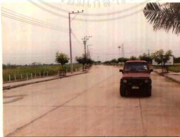
รูปที่ 188 ถนนภายในโครงการ ด้านหน้าอาคารสโมสร
