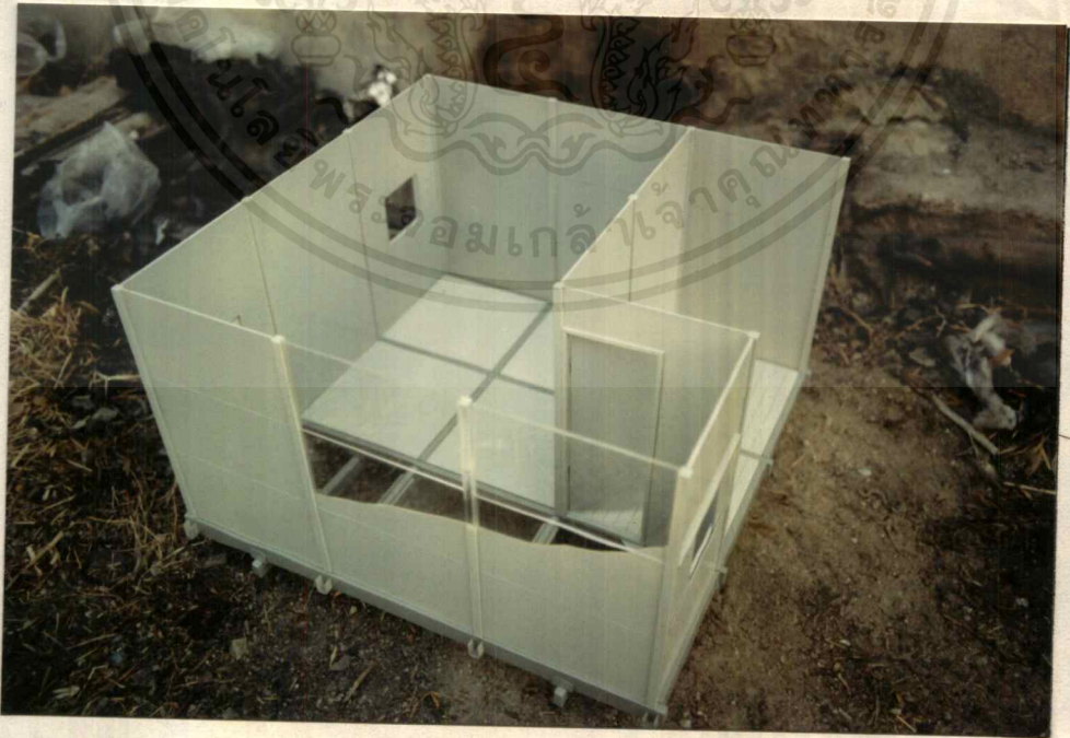
รูปภาพที่ 186 แสดงการประกอบเสาผนัง
