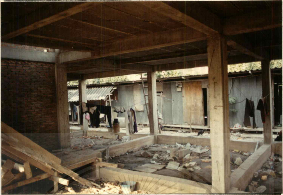
รูปที่136 ลักษณะการระบายอากาศของคนงานที่รื้อฟาด้านหน้าออก แล้วใช้ไม้จริงตีเป็นช่องระบาย
