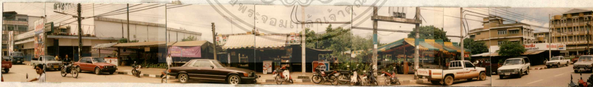
ภาพที่ 4.4 ลักษณะโดยทั่วไปของที่ตั้ง SITE C
