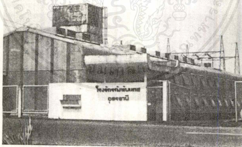
โรงไฟฟ้ากังหันแก๊สอุตรธานี
