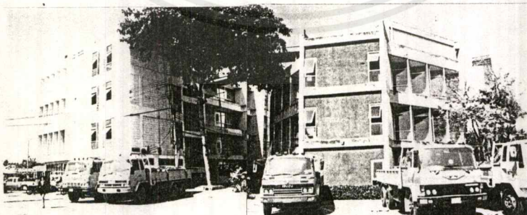
9. อาคารฝ่ายขนส่ง
