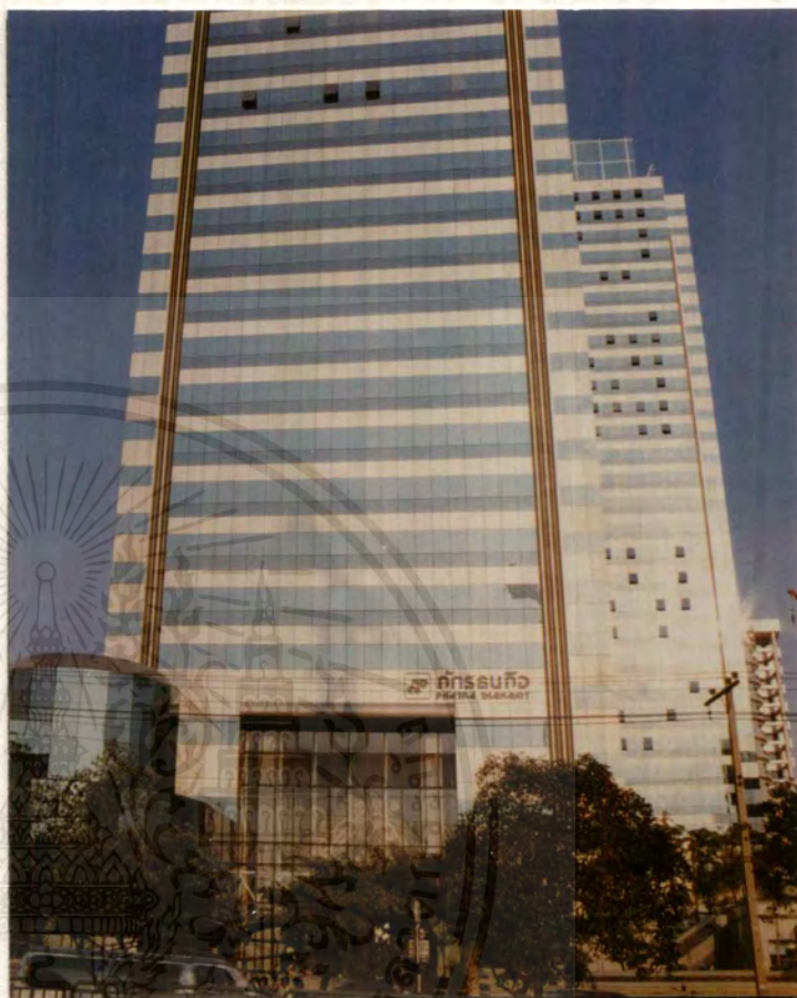
ภาพที่ 3.3 ภาพแสดงลักษณะอาคารภายนอก
