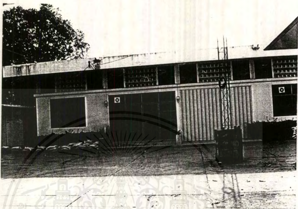
รูปที่ 3.3 ภาพแสดงอาคารฝึกอบรม 2
