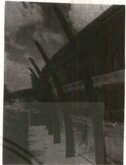
ภาพด้านข้าง แสดงความสลับซับซ้อนของรูปทรงเรือ และองค์ประกอบของโครงสร้าง ผนังกระจกโค้งเพื่อตัดแสงสะท้อนจากท้องฟ้าถูกกำบังด้วยเสาโลหะด้านนอก
