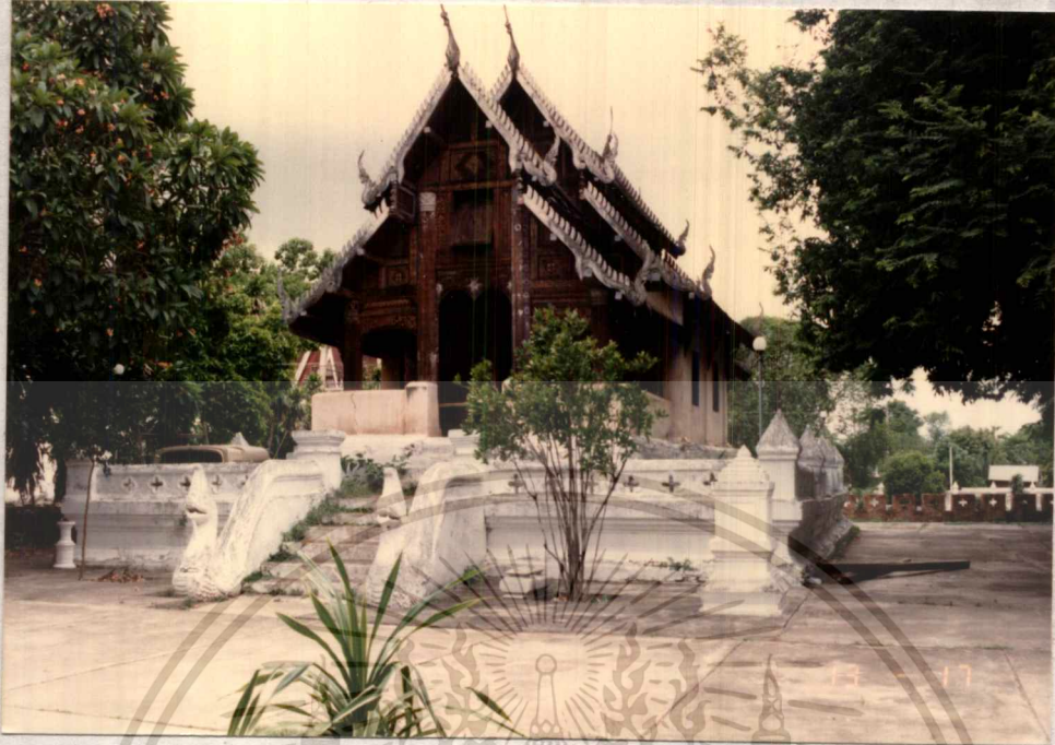
ภาพที่ 63 แสดงอุโบสถวัดสชาดาราม สร้างบนฐานสูง และยกพื้นขึ้นไปอีกชั้นหนึ่ง เป็นแบบที่มีลักษณะปิดล้อม
