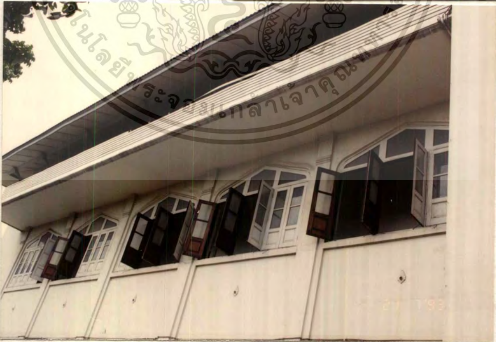
รูปที่ 38 บริเวณช่องแสงของอาคารมีรูปแบบเป็นสามเหลี่ยมหน้าจั่ว
