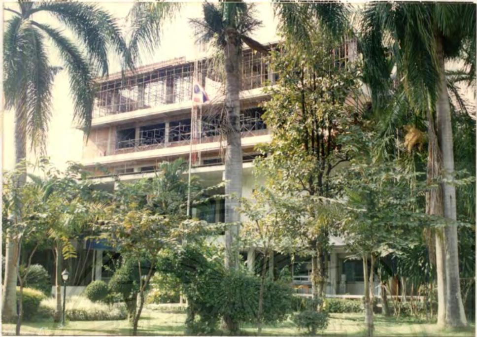
ภาพที่ 72. ทิศใต้ของโครงการตึกอาคารอธิการบดีเดิม
