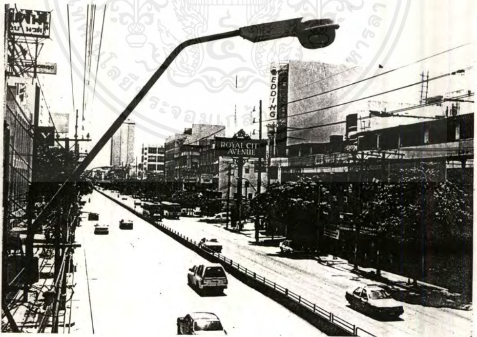
ทางเข้าทางถนนเพชรบุรีตัดใหม่
