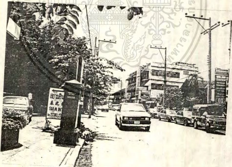
รูปที่ 30 ถนนเจริญประเทศตัดผ่านหน้าโครงการ
