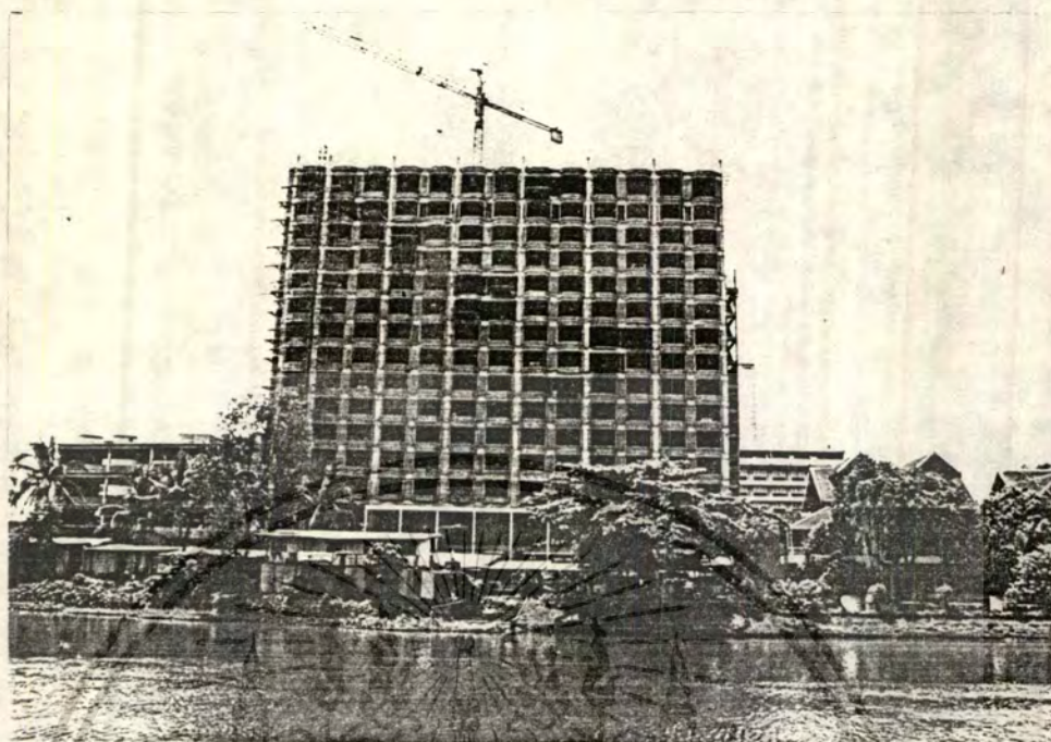
รูปที่ 33 คานหลังโครงการสามารถมองเห็นทิวทัศน์ของลำน้ำปิง โดยอย่างร่มรื่น และสวยงาม
