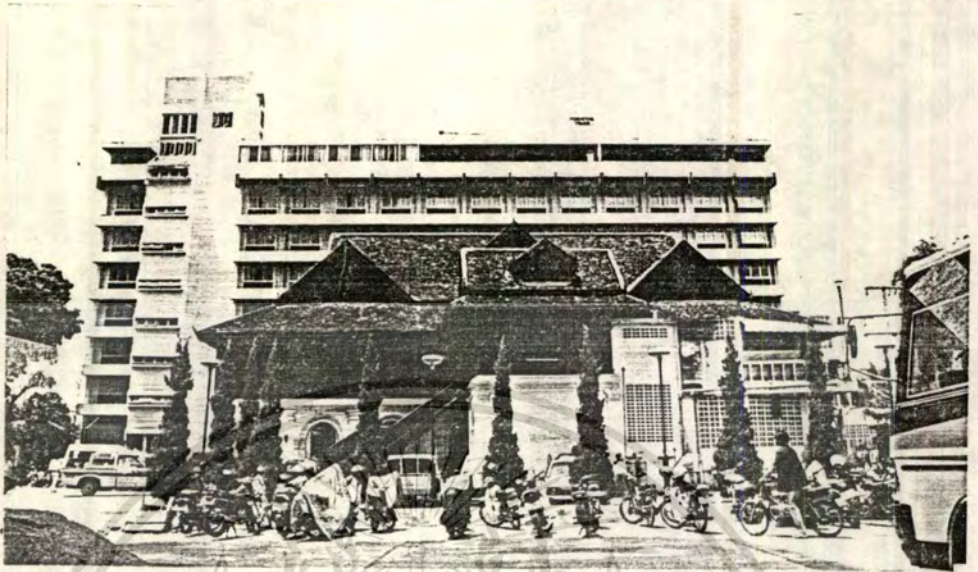
รูปที่ 8 ทิศตะวันตก เป็นทางเข้าสู่โครงการ โดยจะมีถนนเจริญประเทศตัดผ่าน ขนานกับ ทิวอาคารโครงการเดิม ถ้าเข้ามาจะเป็นลานจอดรถของโครงการ
