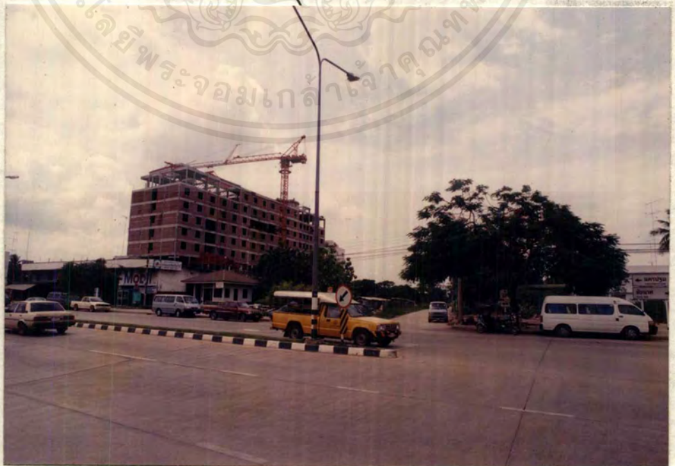
ภาพที่ 72 แสดงภาพทิศใต้ติดต่อกับอาคารพาณิชย์ 3 ชั้น
