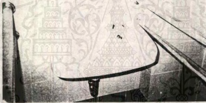
อ่างล้างหน้าสำหรับคนพิการที่ใช้เก้าอี้ล้อเลื่อน สังเกตจะไม่มีแท่นเคาน์เตอร์สำหรับฝึ่งอ่างล้างหน้า เพื่อจะได้สอดเก้าอี้ล้อเลื่อนเข้าไปได้อย่างได้
