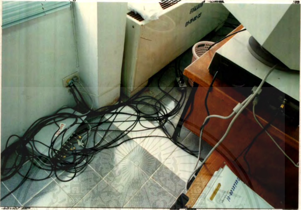
ภาพที่ 2.36 สายไฟที่ไม่ได้รับการใส่ใจ อาจทำให้เกิดอันตรายได้
