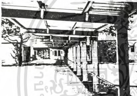
ทางเดินไปยังตึกHEALTH CENTER พยายามหลีกเลี่ยง อันตรายโดยวางเสาไว้ด้านนอกราวจับ อีกด้านไม่มีเสา ยังช่วยให้แสงเข้าได้อีกด้วย
